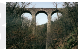
Železniční most v Žampachu
