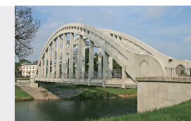
Železobetonový most v Karviné-Darkově
